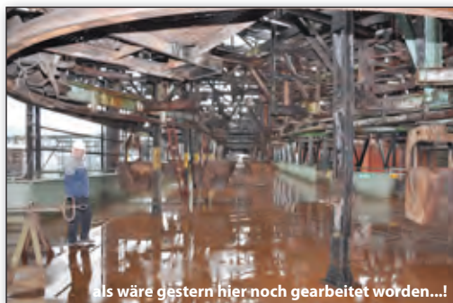
als wäre gestern hier noch gearbeitet worden...!
