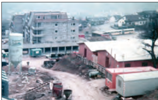
Rohbau der Altenwohnanlage 1983. @ Foto: Andreas Rosar
