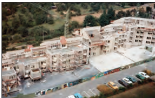
Ibsweg Baustelle Wildgansweg 1983. © Foto: Edmund Rosar
