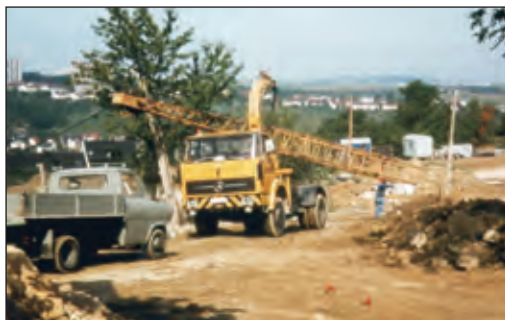
Baustelle Benzenäcker-/Seedlerstraße im September 1976. © Foto: Edmund Rosar
