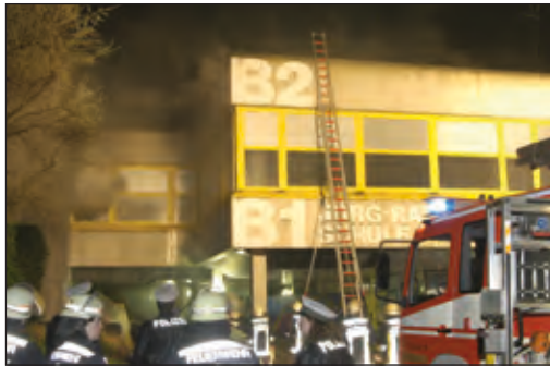
Oben: Rauch dringt aus dem Schulgebäude, als die Einsatzkräfte gegen Mitternacht auf dem Schulgelände eintrafen.
