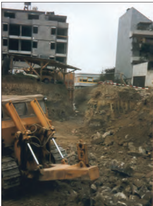
Oktober 1976: Straßendurchbruch am Flamingoweg zum Ladenzentrum und Servicehaus. © Foto: Andreas Rosar
