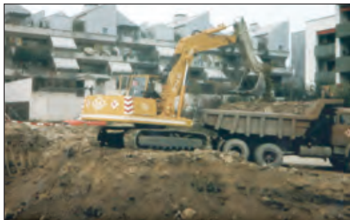
Baustelle Marabu- und Flamingoweg, Straßendurchbruch im Oktober 1976. © Foto: Andreas Rosar
