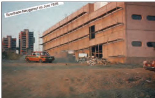
Rohbau der Sporthalle Neugereut im Juni 1976. @ Foto: Edmund Rosar
