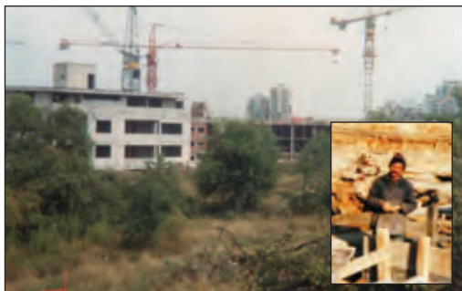
die Altenwohnanlage im Frühsommer 1981 im Rohbau. Hassan (Bauarbeiter, im Bild klein) beim Fundament verlegen. © Fotos: Andreas Rosar
