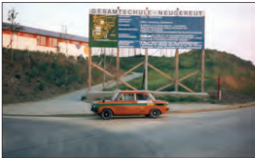
Bautafel zur Gesamtschule (später Jörg-Ratgeb-Schule) Juni 1976. © Foto Rosar
