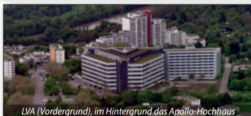
LVA (Vordergrund), im Hintergrund das Apollo-Hochhaus
