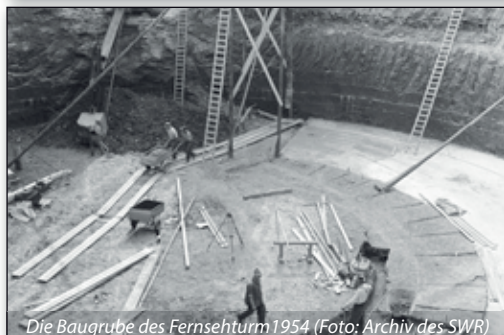
Die Baugrube des Fernsehturm 1954 (Foto: Archiv des SWR)
