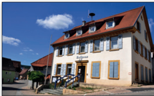
Braunsbach am 07.08.2016: das Rathaus ist bereits saniert
