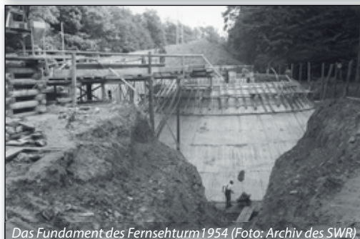
Das Fundament des Fernsehturm 1954 (Foto: Archiv des SWR)
