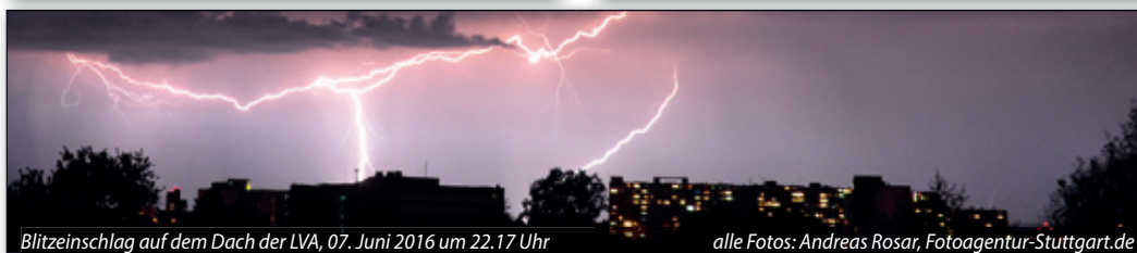
Blitzeinschlag auf dem Dach der LVA, 07. Juni 2016 um 22.17 Uhr
