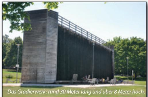
Das Gradierwerk: rund 30 Meter lang und über 8 Meter hoch.
