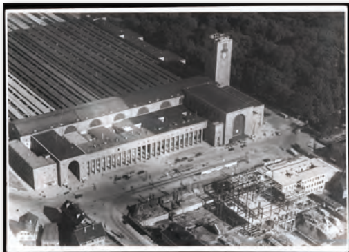
Luftbild der Bauarbeiten am „Hindenburgbau“ im Jahr 1927/28 (Vordergrund). Im Hintergrund ist der Hauptbahnhof zu sehen, rechts davon der dicht bewaldete Schlossgarten.
